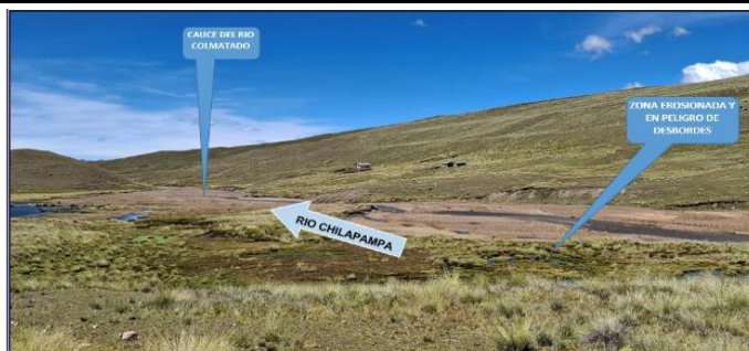
FIGURA 1 y 2 : TRAMO CRÍTICO EN EL RÍO CHILAPAMPA, EN EL SECTOR CHILAPAMPA, DISTRITO DE VILAVILA, PROVINCIA DE LAMPA- PUNO. NOTESE, LA ACUMULACION DE MATERIAL SEDIMENTADO EN EL CAUCE, QUE REQUIERE SER ELIMINADO PARA REESTABLECER LA SECCION HIDRAULICA DE LA CAJA DEL CAUCE EN ESTE SECTOR.
